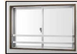
転落防止の手すりの設置
